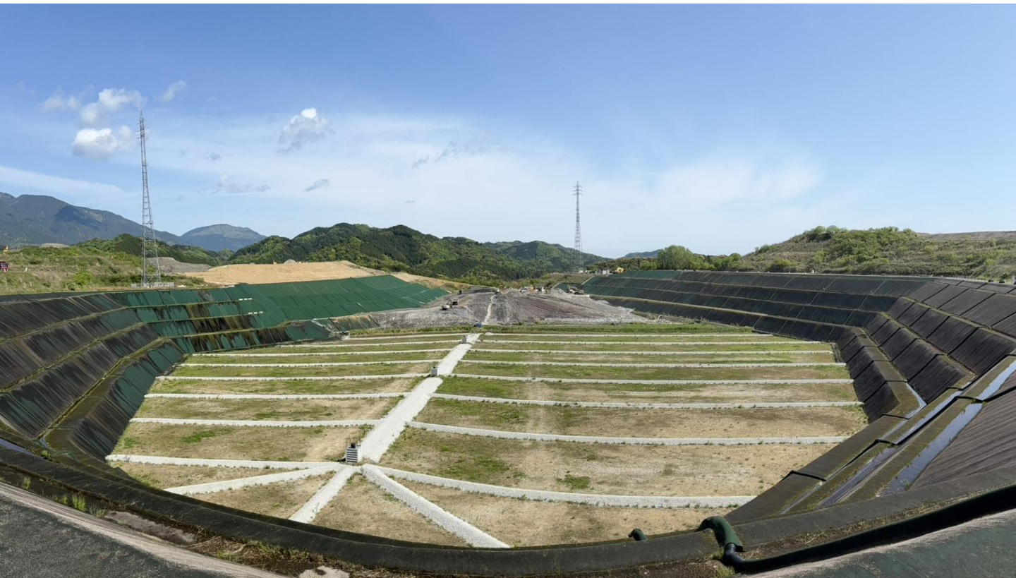
写真③ 新設埋立地の状況(上流側より撮影)
