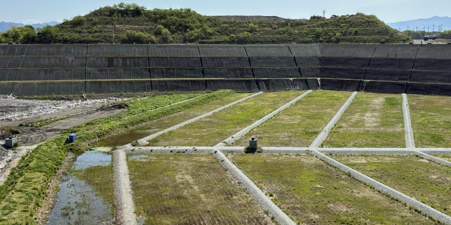
写真⑤ 掘削土仮置場(東側)の法面緑化の状況
