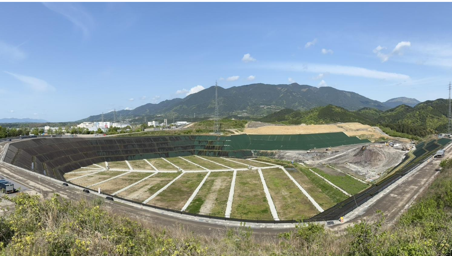
写真④ 新設埋立地の状況(東側より撮影)
