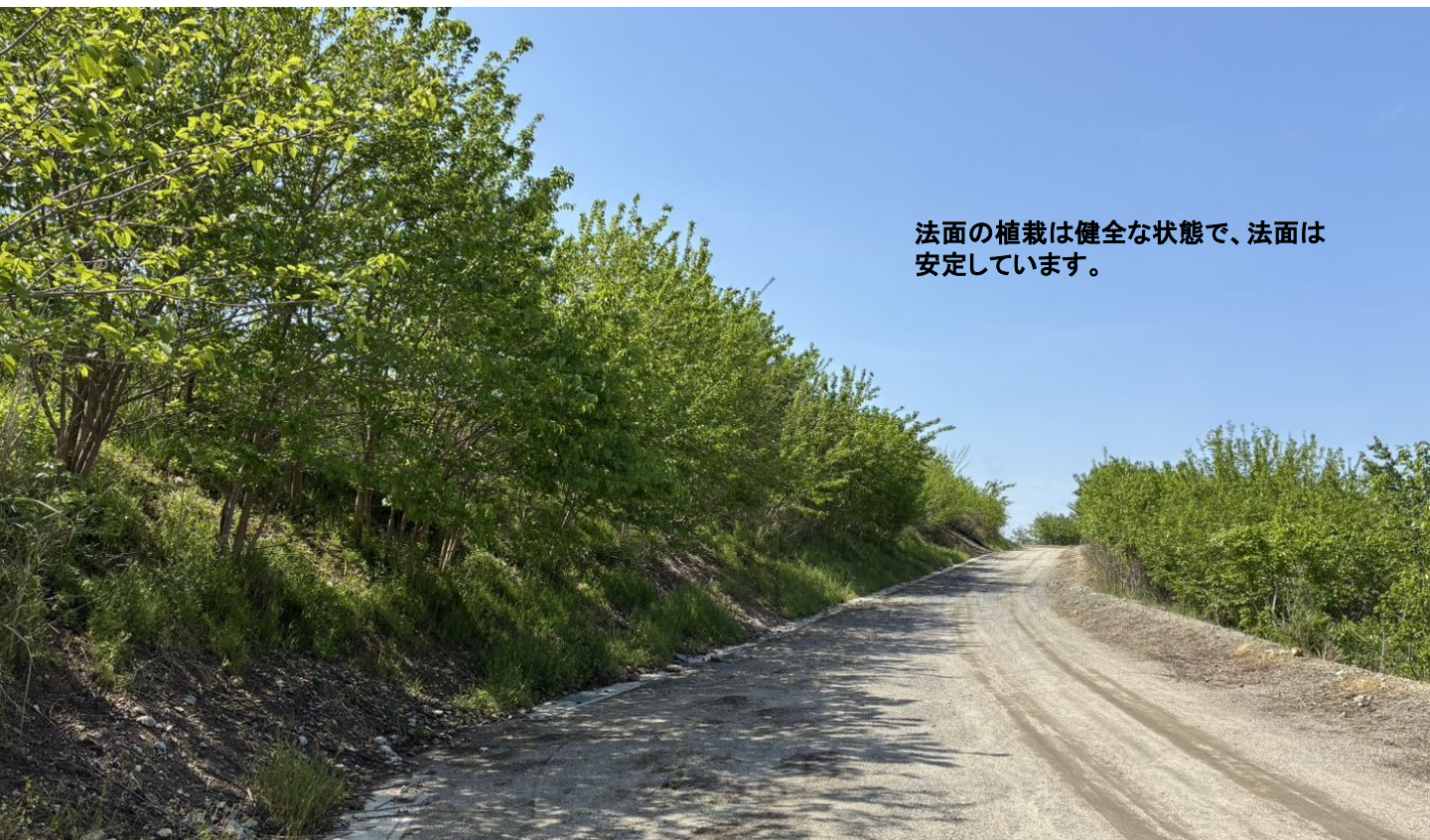
写真⑥ 掘削土仮置場(西側)の法面緑化の状況
