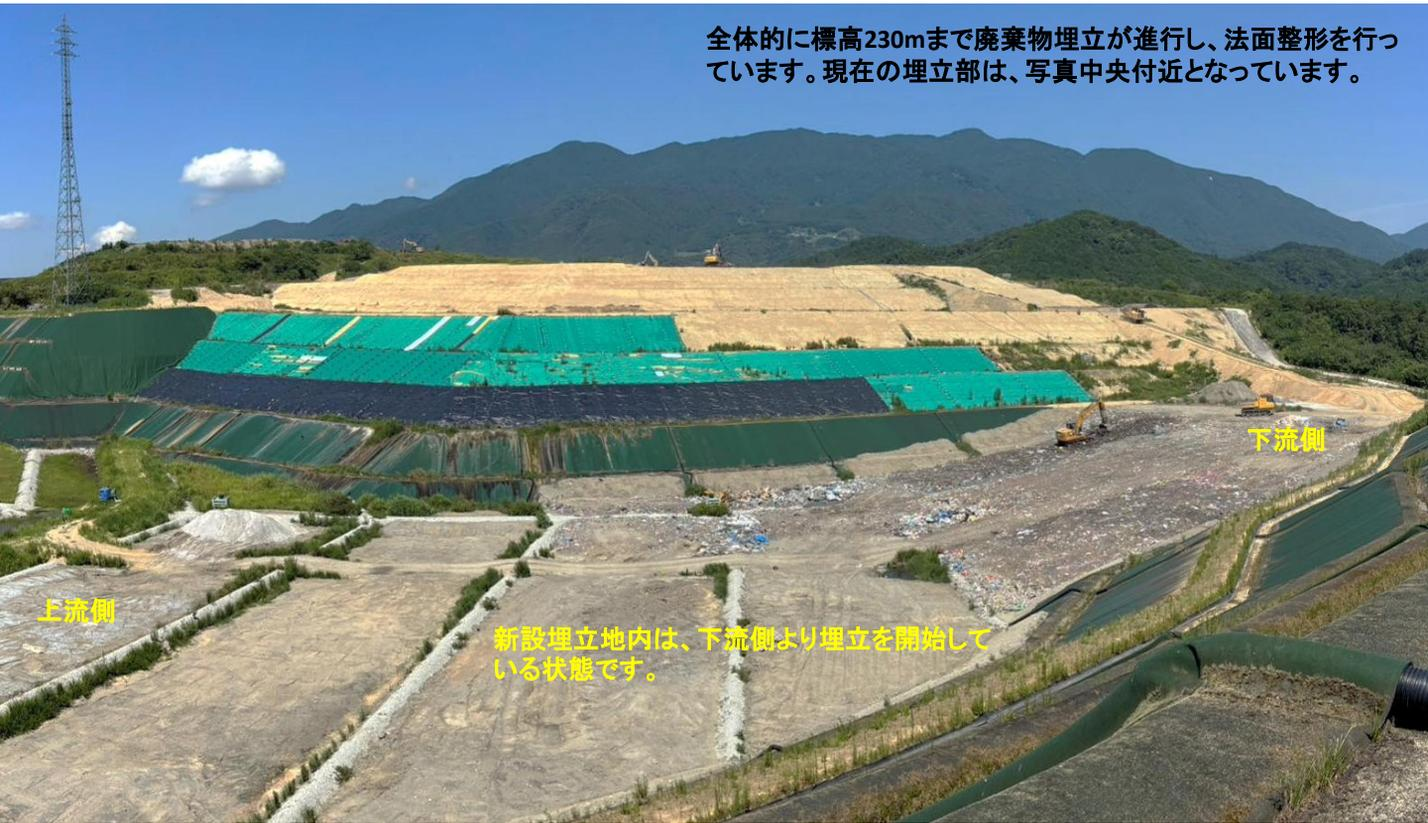
写真① 現在の廃棄物埋立部と新設埋立地北側(下流側)の状況
