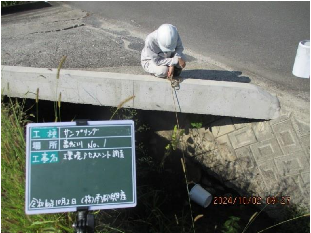
曾我川NO.1地点 (下流側より上流側を撮影)
